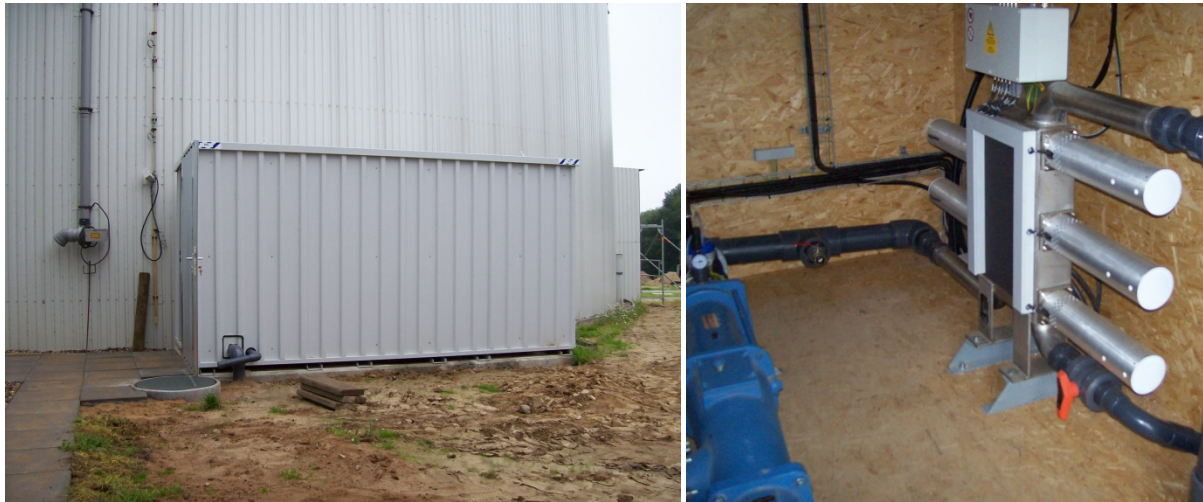
Abbildung 1: Container mit Anlage von außen und innen (mit US-Modul und Pumpe)
